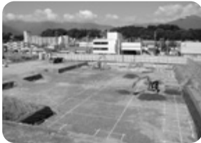
建設工事中の状況
