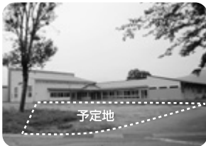
美篤保育園横の建設予定地
